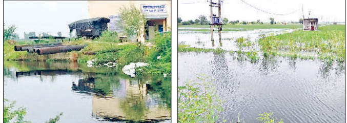
बहादुरगढ़। मातन लिंक ड्रेन का पंप हाउस। इनसेट में खेतों में भरा पानी।
